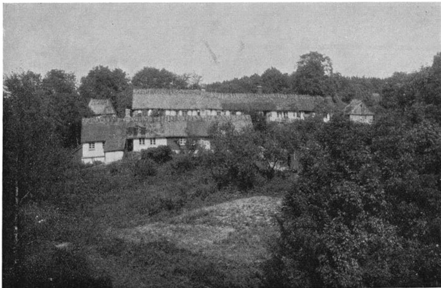
Fig. 10. Arbetarebostäder vid Västra verket. Frühere Arbeiterwohnungen beim Neuen Werk. H. Nelson foto 1927.
